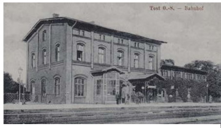
31. Dworzec kolejowy w Toszku w latach 1910
